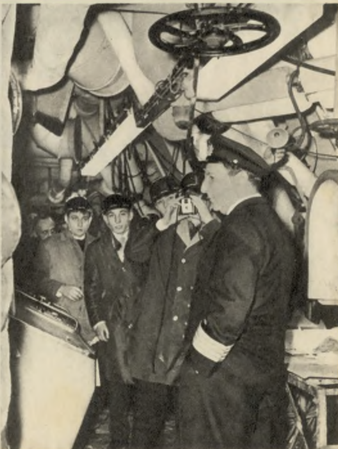
Dans la salle des machines, le chef mécanicien Redner explique le fonctionnement des turbines.
