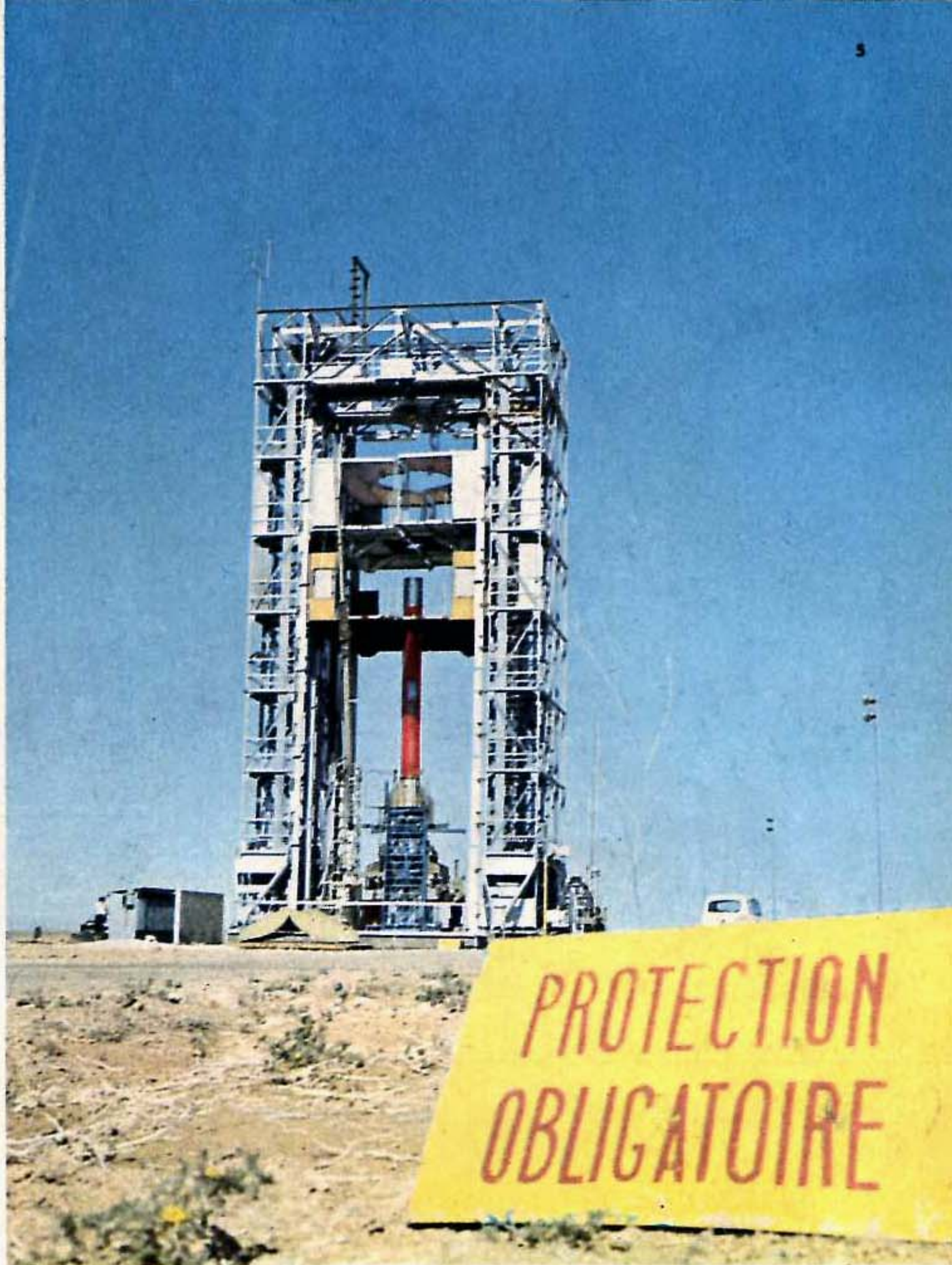
— La Base Blandine : portique permettant la mise en place de la fusée sur sa table de lancement.
