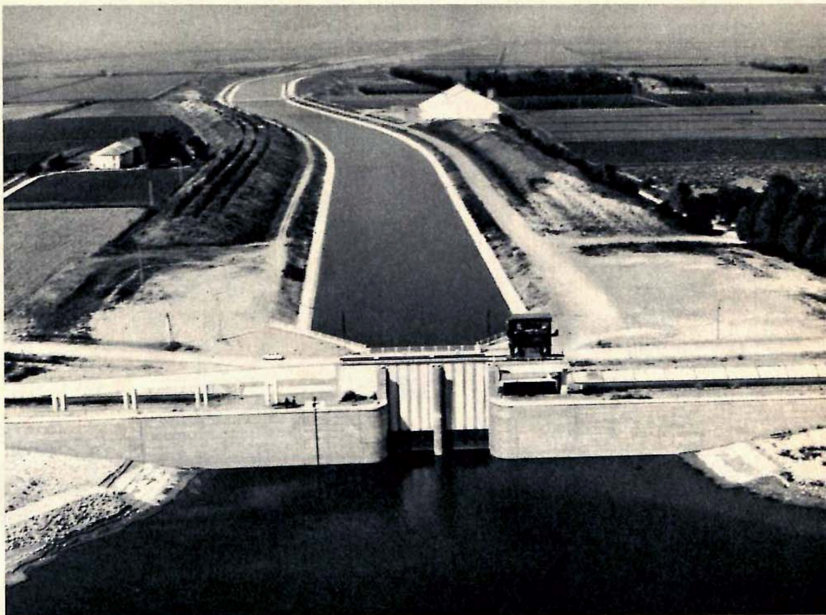
Près du village de Fourques, le Rhône alimente le canal à raison de 73 m 3 /seconde. Le débit du Rhône est ici de 1600 m 3 seconde.
